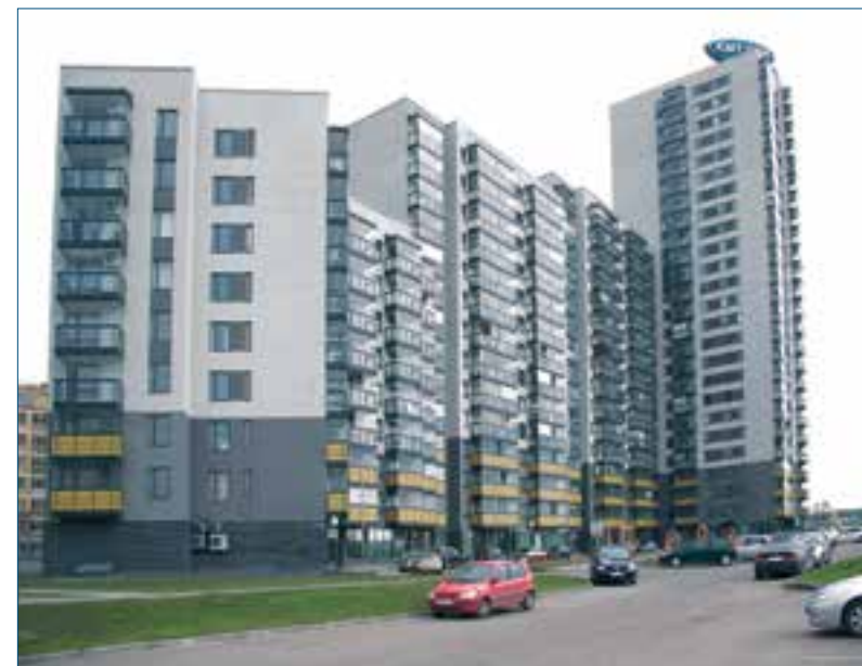
Этот жилой дом, построенный в Казани в 2011 году, отображает новый облик проектов жилищного строительства ЮИТ в России. На крыше здания установлена реклама «ЮИТ Дом».
