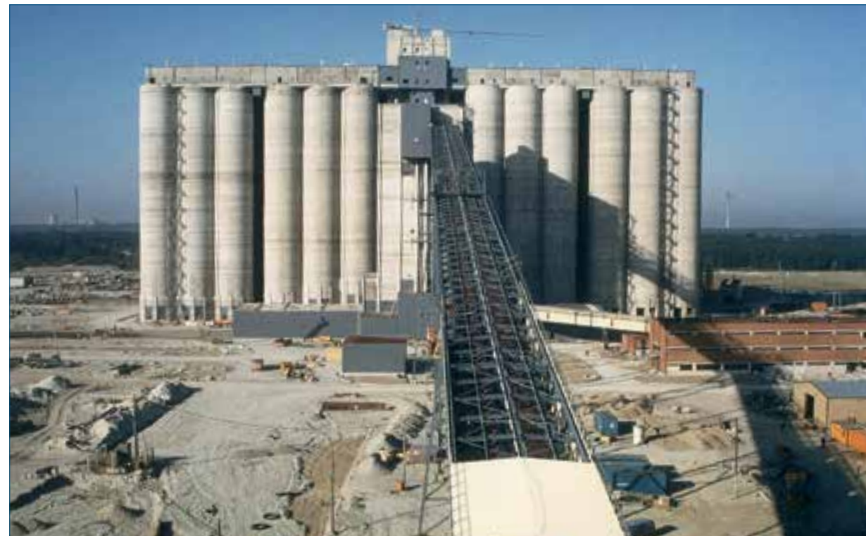
Рабочий консорциум пяти финских строительных компаний в 1984-1986 годах осуществил под руководством «Юлейнен Инсинееритоймисто» подряд по созданию зернового порта в Таллине. На фотографии – завершение строительства зернового элеватора.
