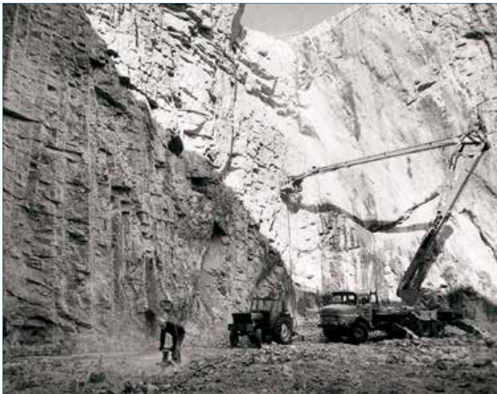
Строительство Костомукшского комбината требовало значительных объемов разработки скального грунта. Фотография 1978 года.
