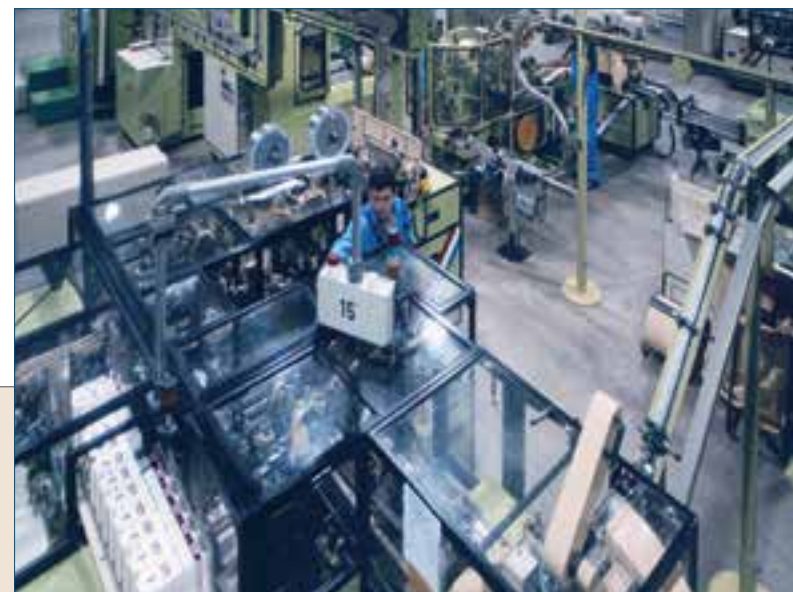
Монтажные работы на табачной фабрике «РДЖР Петро» в Санкт-Петербурге. ЮИТ реконструировала предприятие в 1997-1999 годах.
