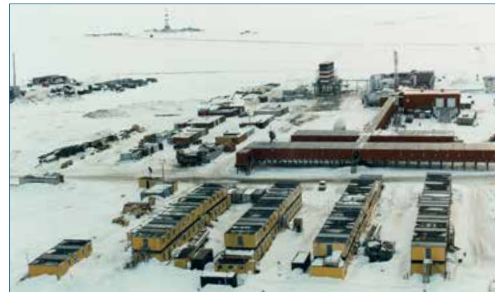
Общий вид стройплощадки Ардалинского месторождения нефти в середине 1990-х годов.
