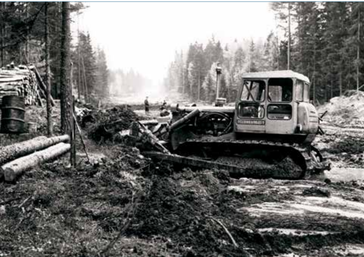
Тракторы «Пеллонрайваус Ою» расчищали дорогу в Тулома со скоростью 1 км в сутки.
