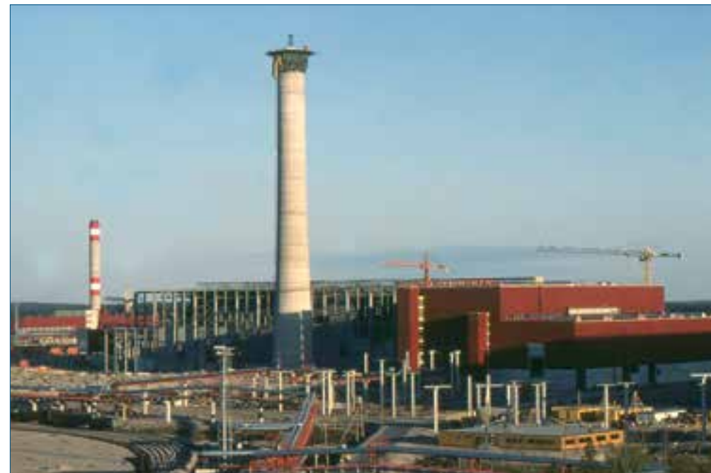
Строительство фабрики по обогащению железной руды было крупнейшим отдельным подрядом в Костомукше. В работе приняла участие «Юлейнен Инсинееритоймисто». Здание фабрики сдано в 1981 году.
