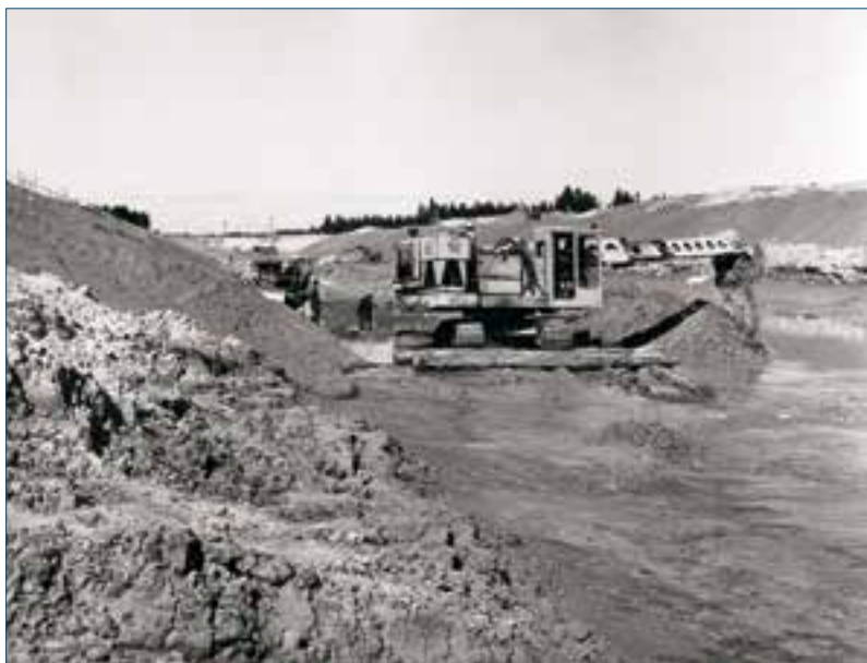
14 | Экскаватор «Восто Ою» на землеройных работах Сайменского канала.
