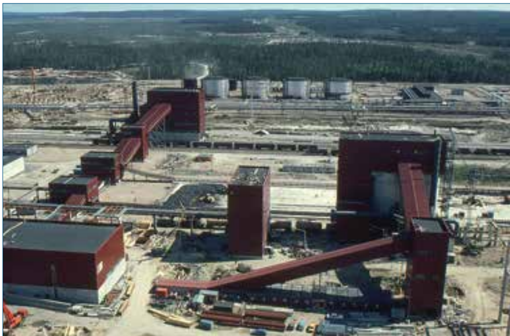
Силосы для дробления железной руды были возведены в Костомукше при строительстве первой очереди комбината в 1978-1982 годах.
